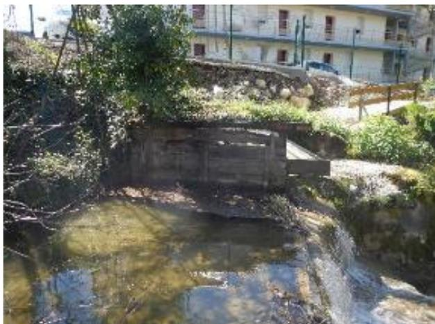
*Figure 57: Fond colmaté en amont de la prise d'eau*
