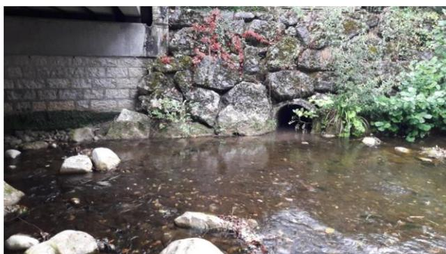
*Figure 80: Buse d'évacuation des eaux pluviales en amont des ponts des dames en partie engravée, témoignant d'un rehaussement du fond du lit depuis sa mise en place*
