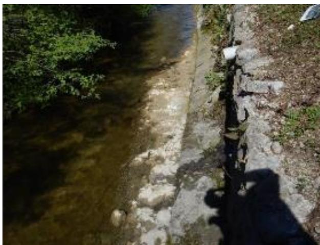
*Figure 59: Banquette localisée en enrochement bétonné resserrant faiblement la lame d'eau*
